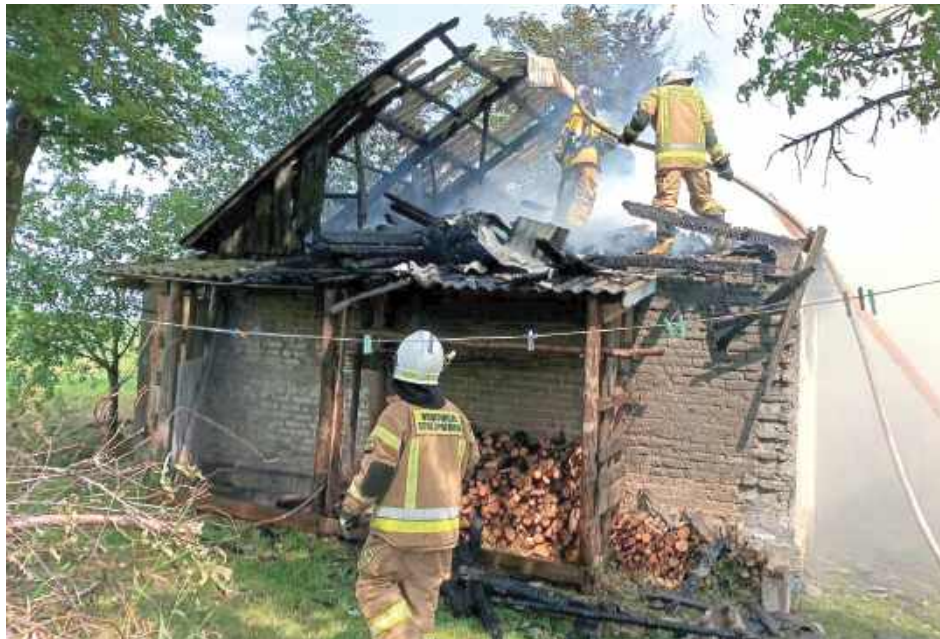
Pożar obejmował budynek gospodarczy z dobudowaną szopą, gdzie składowane było drewno
