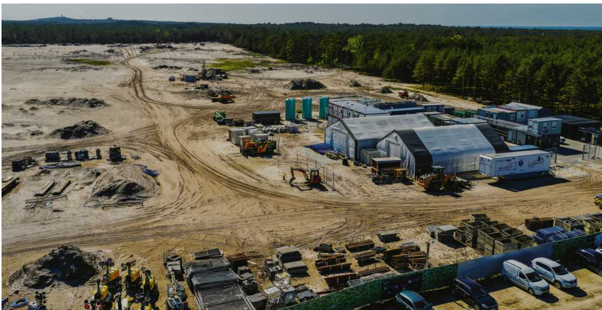
Teren prac przygotowawczych do budowy elektrowni jądrowej Lubiatowo-Kopalino. Źródło: Fot. PEJ
