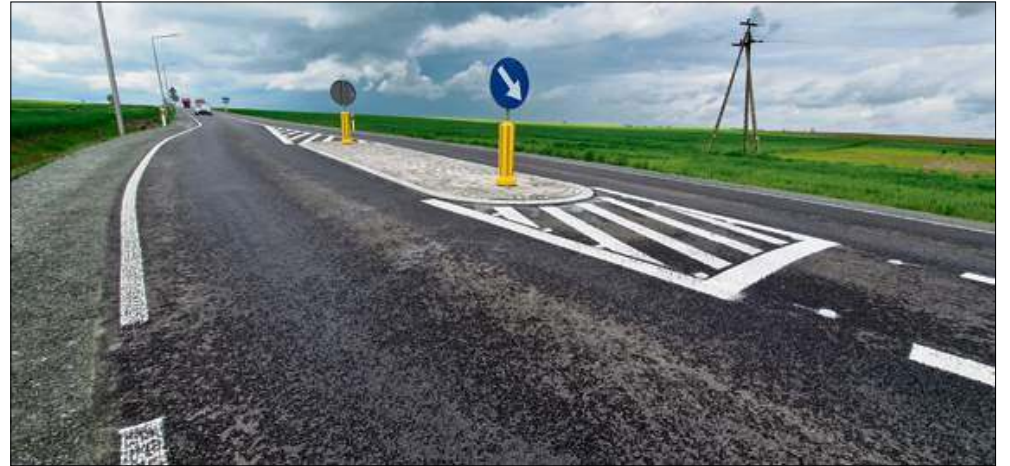
Zakończył się remont drogi wojewódzkiej pomiędzy Kórnicą a Ściborowicami.
