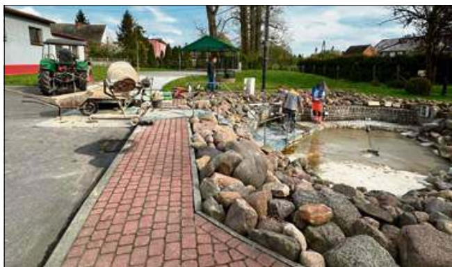
Panowie wyremontowali fontannę przy remizie strażackiej.
