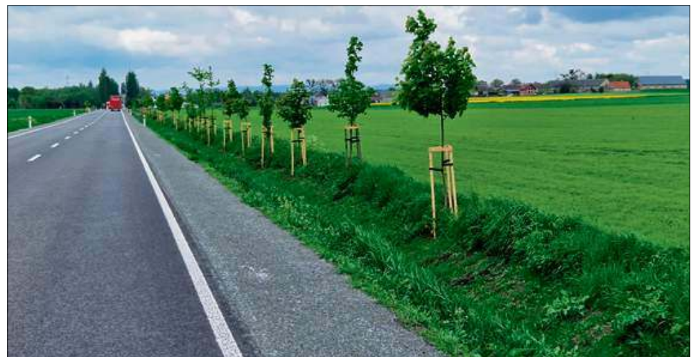
Przebudowano dwukilometrowy odcinek DW 416.
