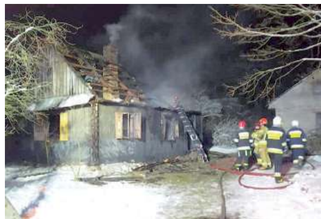
Drewniany budynek uległ niemal całkowitemu spaleni. Zginął w nim samotny mężczyzna (fot. OSP Jedlanka)
