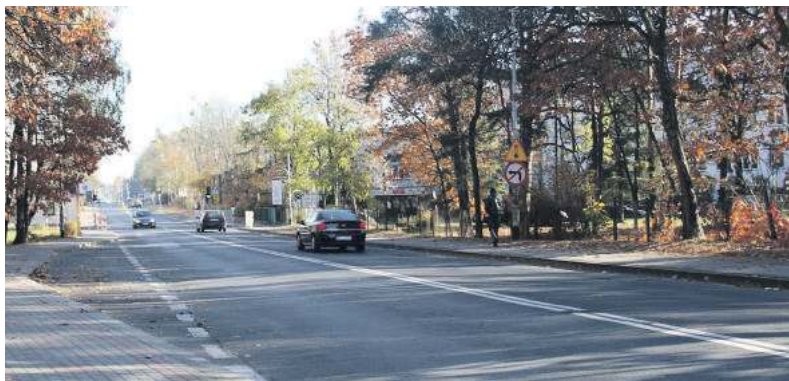
Droga, która zostanie wyremontowana ciągnie się od przejazdu kolejowego, przy Karczmie Biesiada, do ronda Pileckiego
