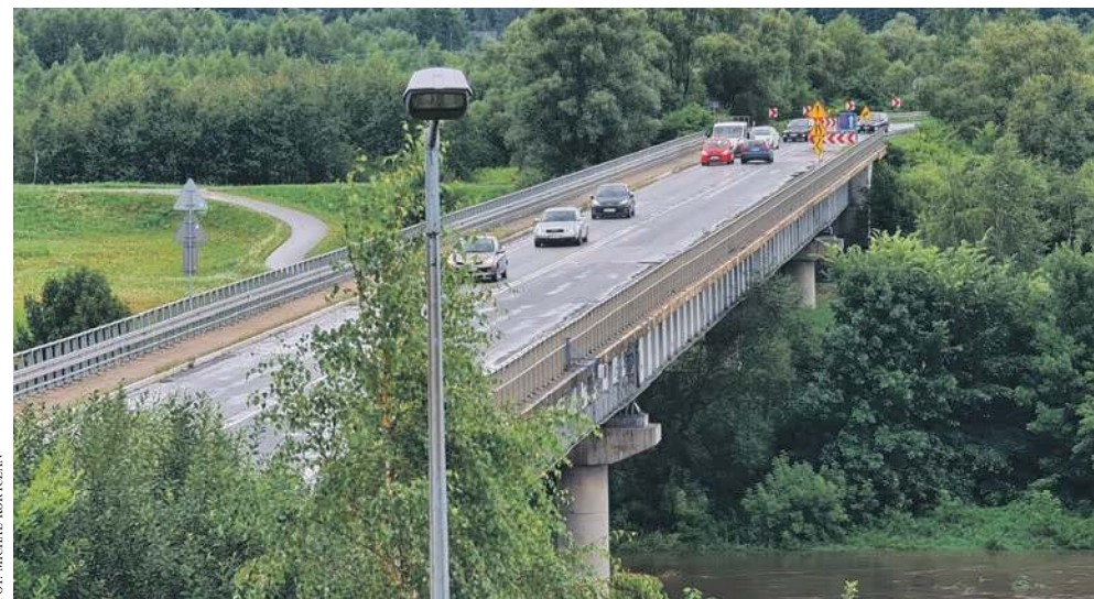
Widok na most w Jankowicach
