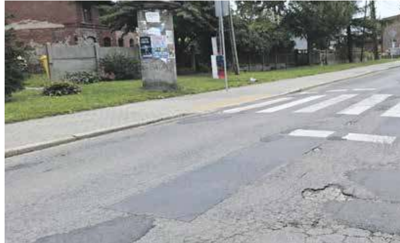
Jeśli pogoda pozwoli, remont ruszy za niespełna dwa miesiące
