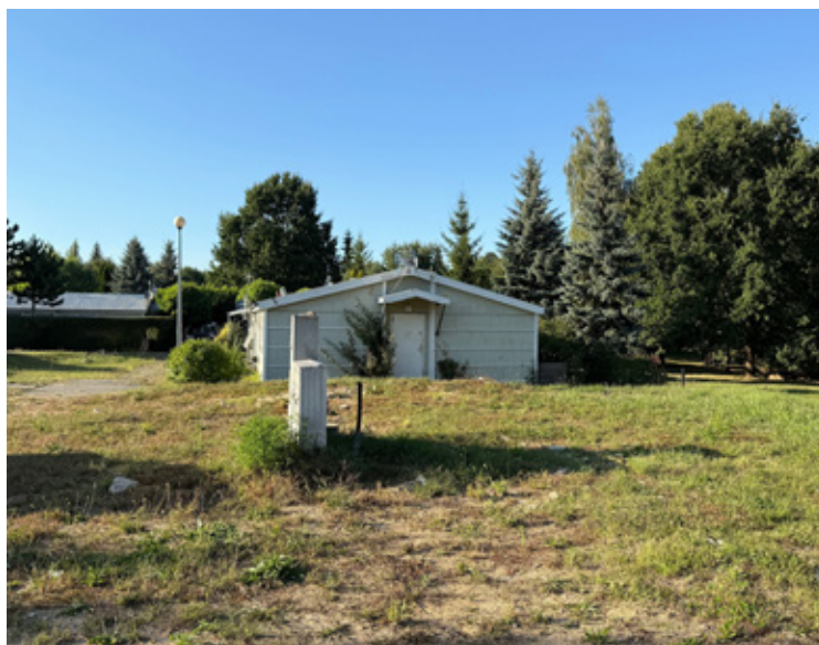
Przy ulicy Małopolskiej powstanie nowoczesny budynek mieszkalny.
