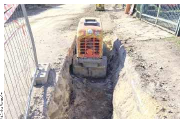
Kanalizacja w ul. Ogrodowej w Markuszowie powstaje na odcinku o długości blisko 120 metrów
