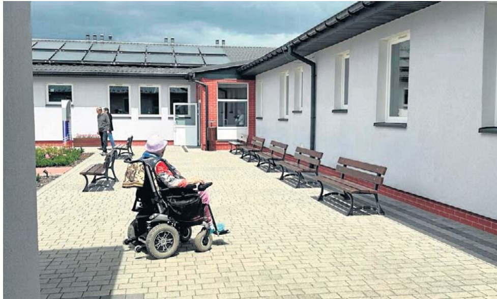
Budowa hospicjum w Tarnobrzegu - Miechocinie trwała wiele lat, prace zakończone w 2025 roku. Koszt inwestycji to prawie 5 milionów złotych
