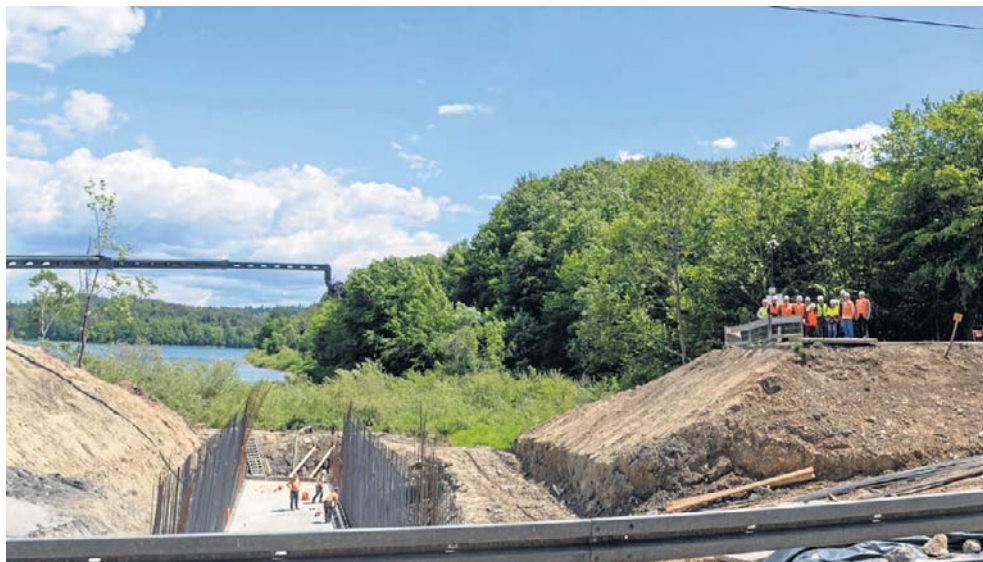
Na drodze wojewódzkiej nr 894 na odcinku Polańczyk - Wołkowyja powstaną m.in. dwa mosty. Wzdłuż trasy budowana jest także ścieżka rowerowa
