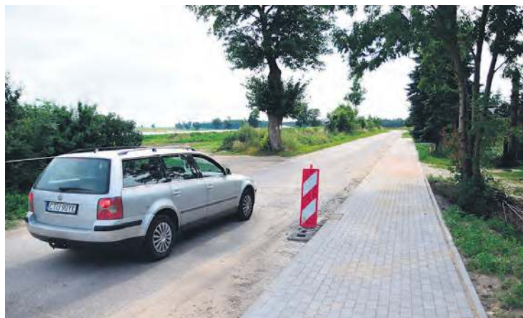
Inwestycja chodnikowa jest zakończona. Teraz czas na asfalt.
