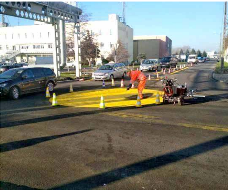
6 grudnia firma Strabag zakończyła pierwszy etap przebudowy ulicy Pierwszej Brygady
