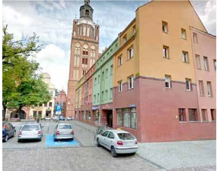
Urząd Gminy planuje remont budynku przy ulicy Rynek Staromiejski 5
