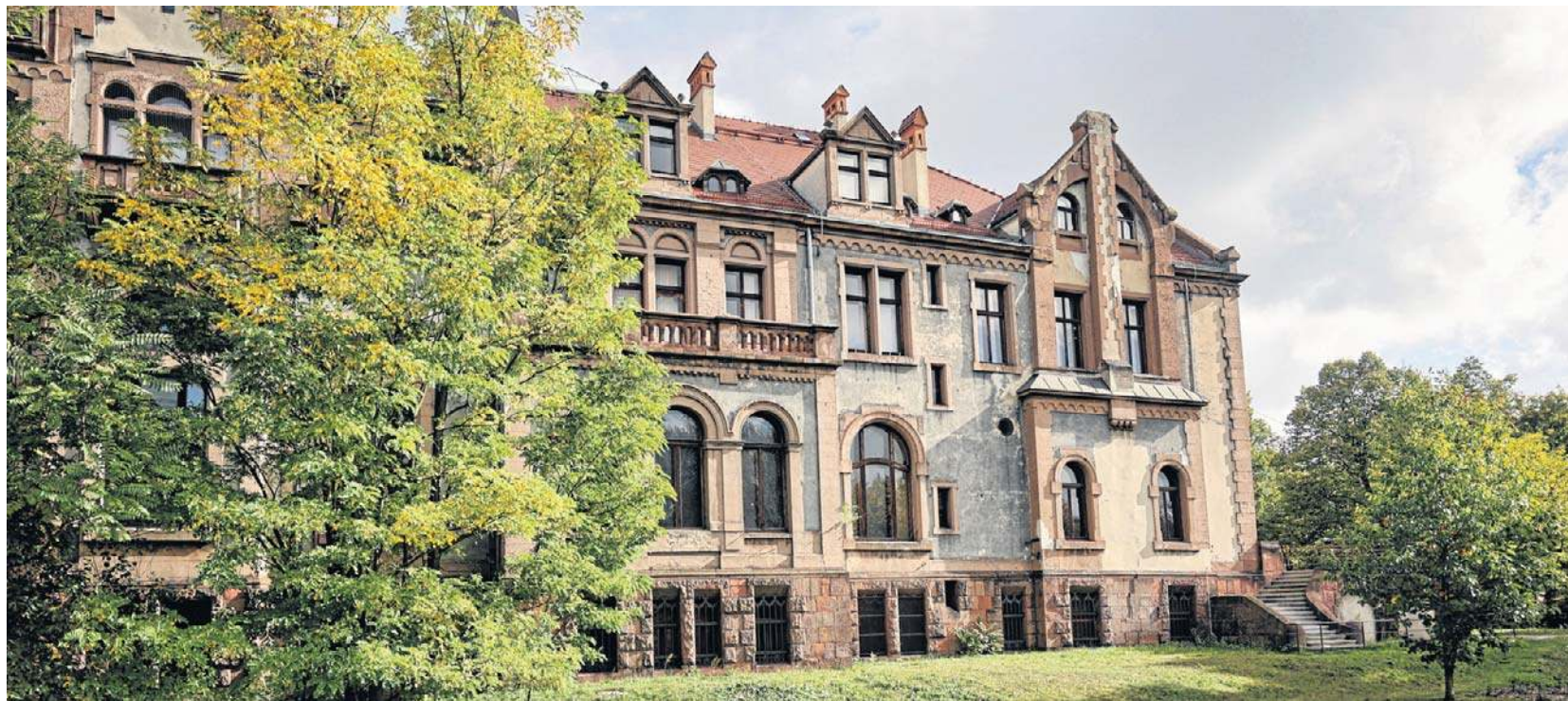
Pałac Schöenów wybudowany jest w stylu eklektycznym, na który prócz charakterystycznej wieży w stylu gotyku angielskiego składają się również style: neoromański, neorenesansowy, neobarokowy i secesyjny. Budynek wymaga gruntownej modernizacji
