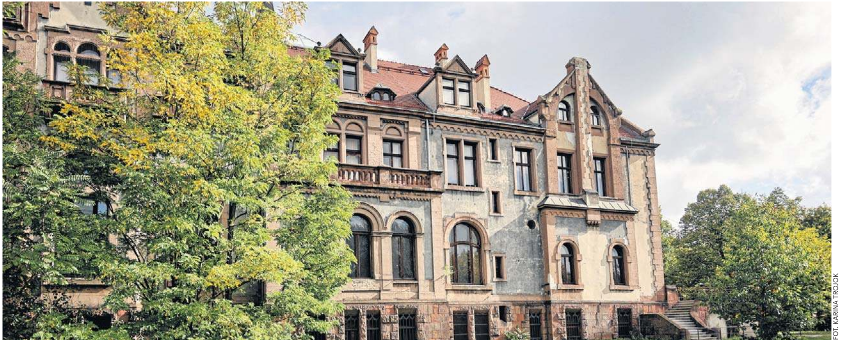
Pałac Schöenów wybudowany jest w stylu eklektycznym, na który prócz charakterystycznej wieży w stylu gotyku angielskiego składają się również style: neoromański, neorenesansowy, neobarokowy i secesyjny. Budynek wymaga gruntownej modernizacji
