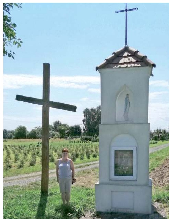
- Kapliczka miała jedynie niezniszczony dach, reszta była już mocno zniszczona, płacami odpadało wapno, którym była pobielona. Została otynkowana, ma wymienione okienko i ułożoną wokół kostkę - opowiada Alicja Szczepańska, sołtys wsi Białobrzegi
