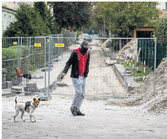
Remont sieci ciepłowniczej KPEC na ulicy 11 listopada w Bydgoszczy
