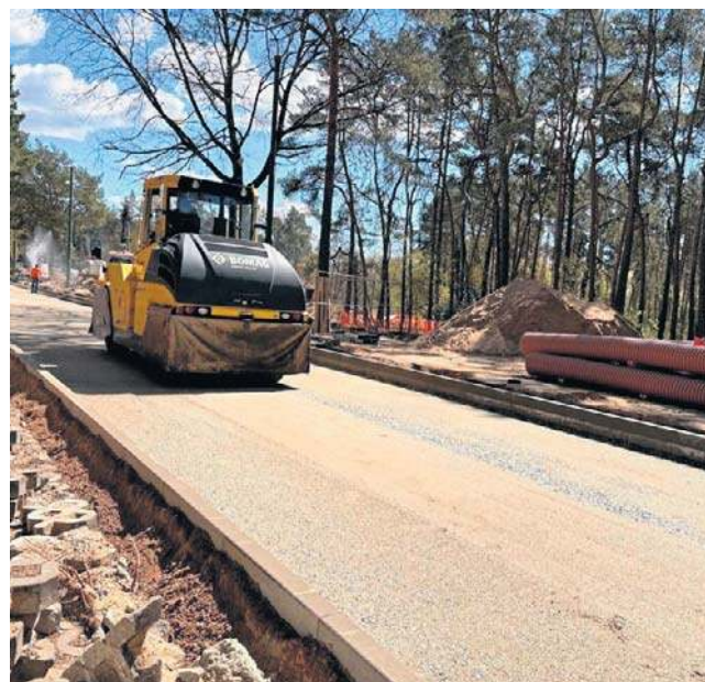
Prace na Rekreacyjnej trwają od niespełna 2 miesięcy. 1 maja przywrócono tam ruch samochodowy
