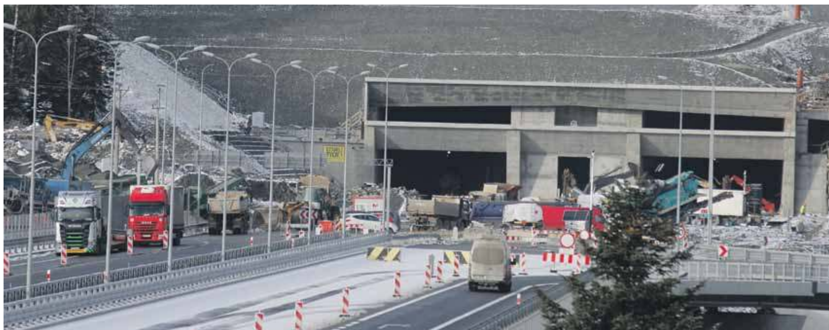
Południowy wlot do tunelu pod Małym Luboniem.
