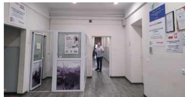
Miasto Garwolin zakończyło modernizację oświetlenia w budynku Urzędu Miasta, wprowadzając nowoczesne i energooszczędne rozwiązania LED
