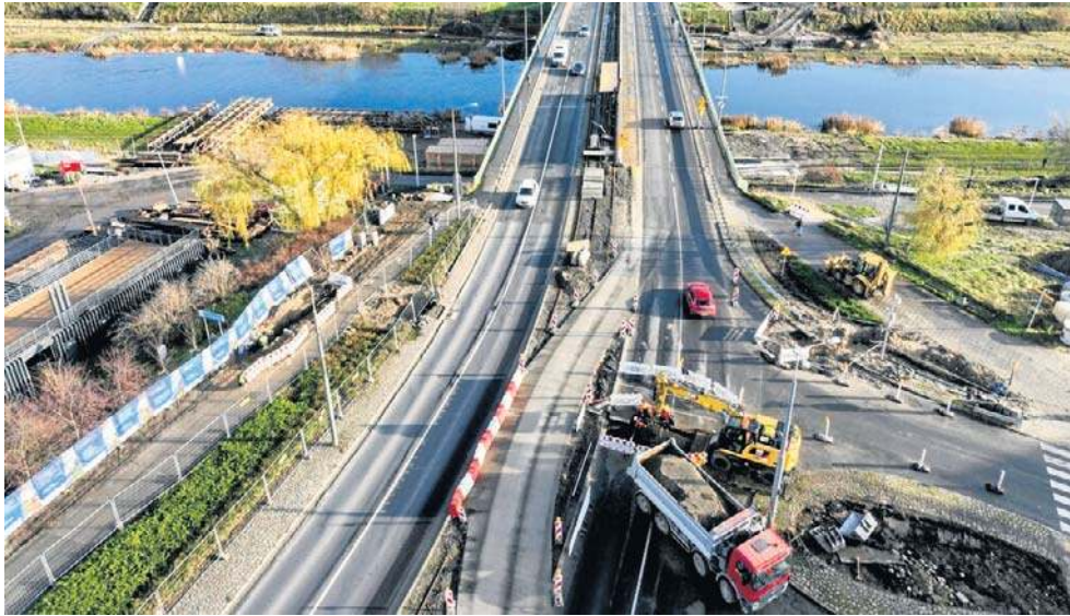
Postępy na budowie mostu Chrobrego? Efekty prac będziemy mogli dostrzec za miesiąc. Do 18 stycznia wykonawca powinien rozebrać północną nitkę mostu
