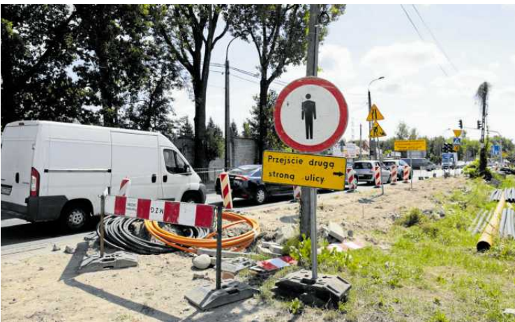
• Przebudowa skrzyżowania ul. Arkuszowej z ul. Estrady
