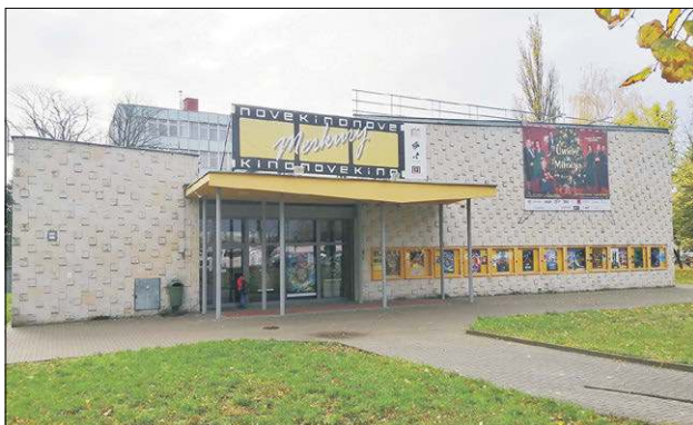
W przejętym budynku kina Merkury miasto chce stworzyć salę widowiskowo-koncertową
