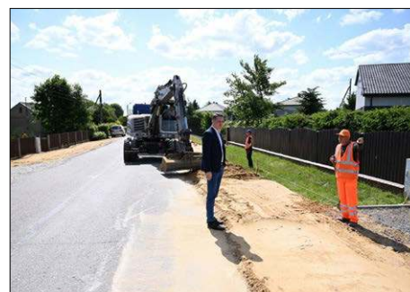
Prace w terenie mają ruszyć jeszcze w tym roku
