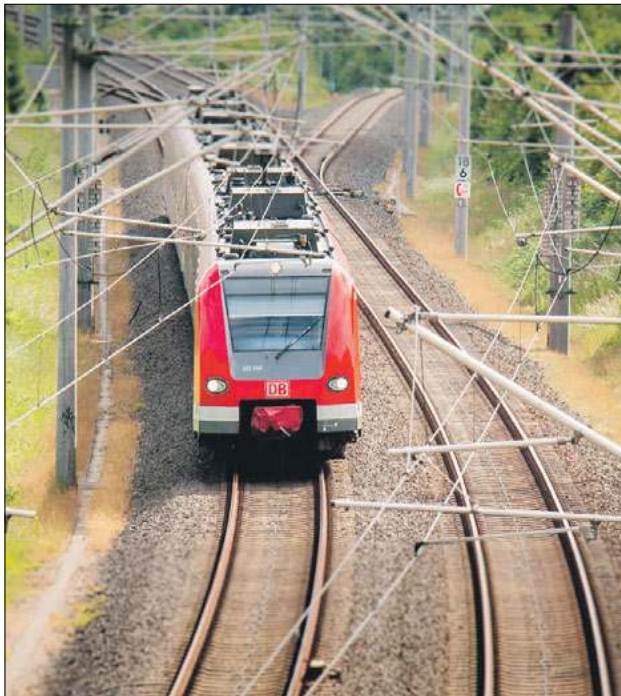
Zakończył się wielki projekt zakładający modernizację sieci linii kolejowej na odcinku Parczew-Lubartów. Całkowita wartość inwestycji to ponad 122 mln zł
