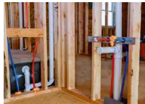
🔗 W domu prefabrykowanym najlepiej jest z góry dokładnie zaplanować każdy element – od konstrukcji po rozmieszczenie rur. ADOBE STOCK
