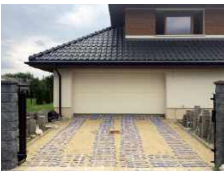
❷ Na podjeździe, wystarczy ogrzewać tylko tor jazdy kół auta oraz przestrzeń pod bramą. RAYCHEM
