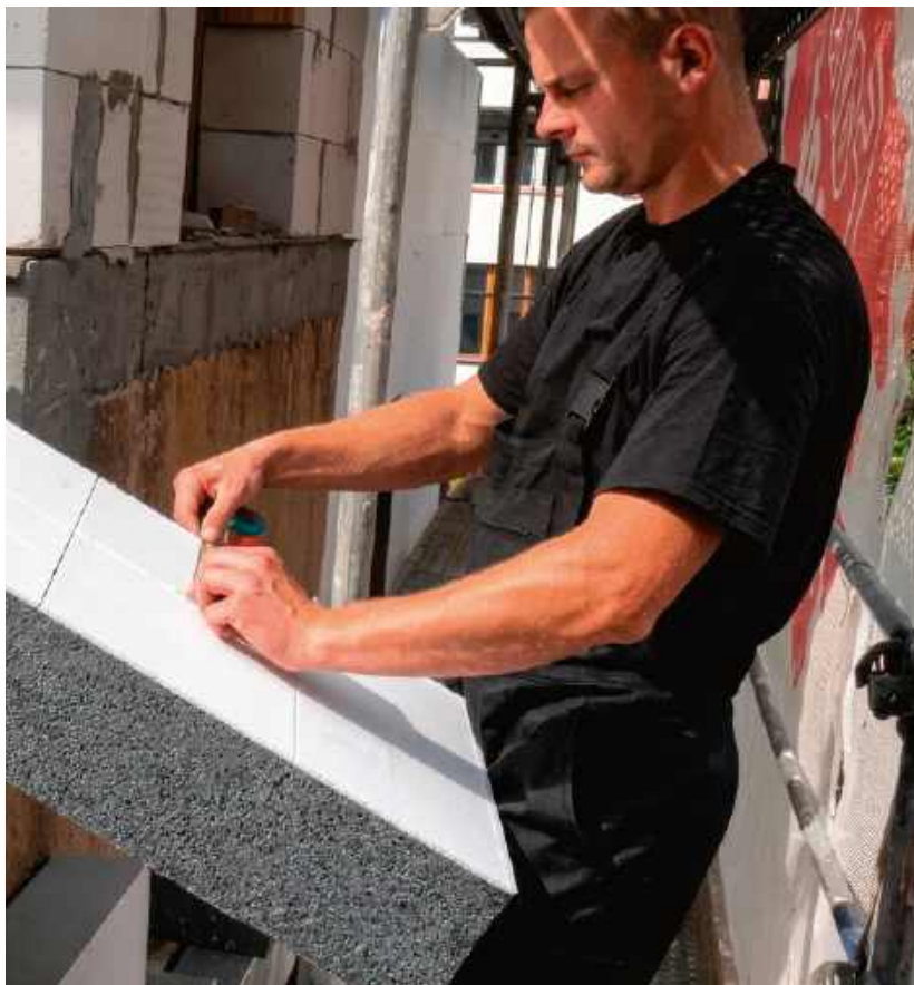
📌 Wszystkie odmiany styropianu oraz XPS (polistyrenu ekstrudowanego) charakteryzuje znikoma paroprzepuszczalność oraz niska nasiąkliwość. Pod tym względem wełna mineralna jest jego przeciwieństwem. swisspor
