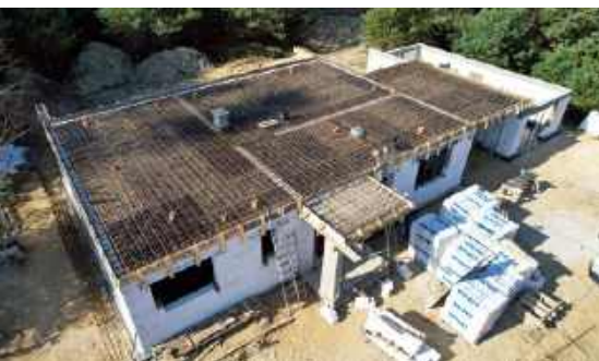
🔧 Przygotowanie szalunków i zbrojenia stropu to około 7 dni pracy. T. RYBARCZYK
