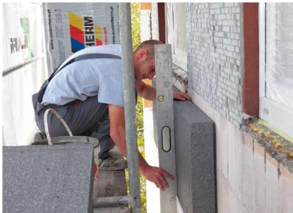
🔗 Za ocieplenie ścian styropianem zapłacimy 200–300 zł/m 2 . Robocizna kosztuje tu więcej niż materiały. AUSTROTHERM
