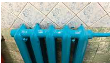
❶ Stare grzejniki częściej wymienia się ze względów estetycznych niż technicznych. ADOBE STOCK
