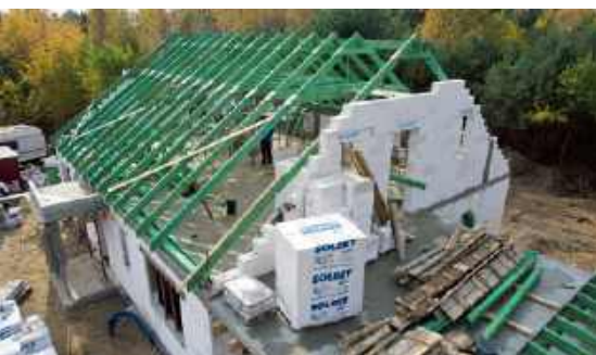
🔧 Montaż więźby trwa do tygodnia. Można w tym samym czasie kończyć ściany szczytowe. Wykonanie pokrycia dachowego – łączenie należy już do dekarzy. T. RYBARCZYK
