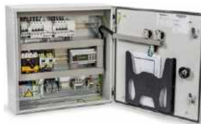
☑ Sterownik umieszcza się w skrzynce montażowej, w której znajdują się inne zabezpieczenia, np. wyłącznik różnicowoprądowy. Niektóre sterowniki są wyposażone w moduł Wi-Fi, dzięki czemu systemem można sterować za pomocą smartfona. Sterowniki kosztują 300–1500 zł. RAYCHEM
