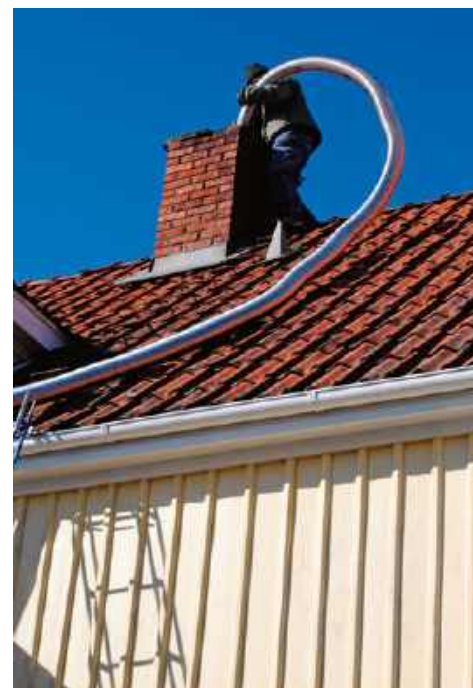
📍 Wymiana kotła bardzo często oznacza również konieczność wyposażenia komina w wkład. ADOBE STOCK
