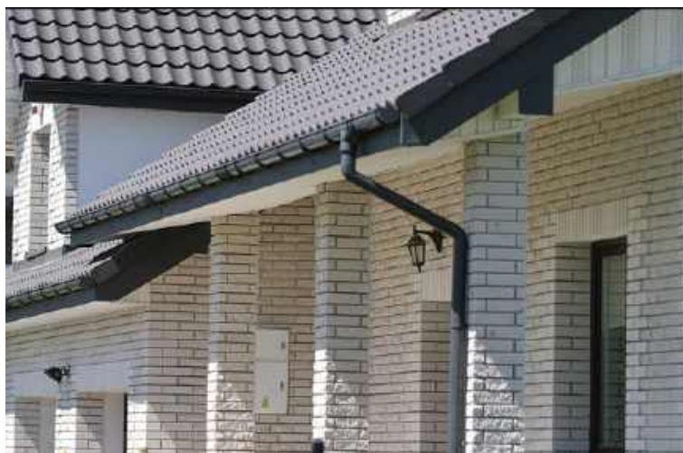
❷ Ściana trójwarstwowa ma solidną i trwałą warstwę elewacyjną w postaci muru grubego zwykle na 12 cm. GRUPA SILIKATY
