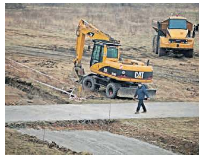
Ciężki sprzęt na budowie drogi koło alei Bora-Komorowskiego
