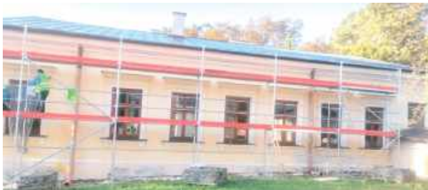
Obecnie trwają jeszcze prace przy wykonywaniu elewacji budynku głównego pałacu
