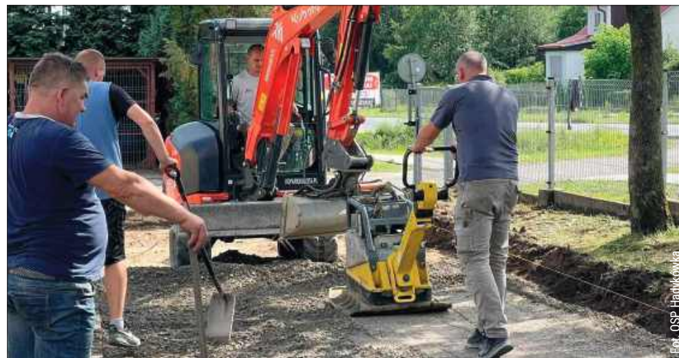
Druhowie z Hadykówki postanowili sami wykonać prace.
