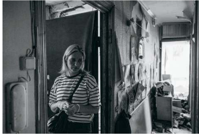
Mieszkanie zniszczone na skutek ataku raketowego. Kijów, sierpień 2025 r.
