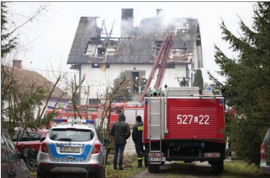
➦ Prawdopodobną przyczyną pożaru przy ul. Struga w Kłoczewie było zapalenie się sadzy w kominie
