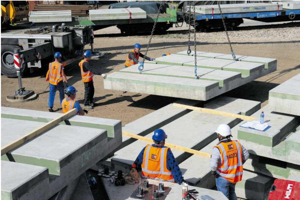
• Rozładunek betonowych elementów pl. Zawiszy, które przyjechały z Krakowa FOT. ROBERT KOWALEWSKI / AGENCJA WYBORCZA.PL
