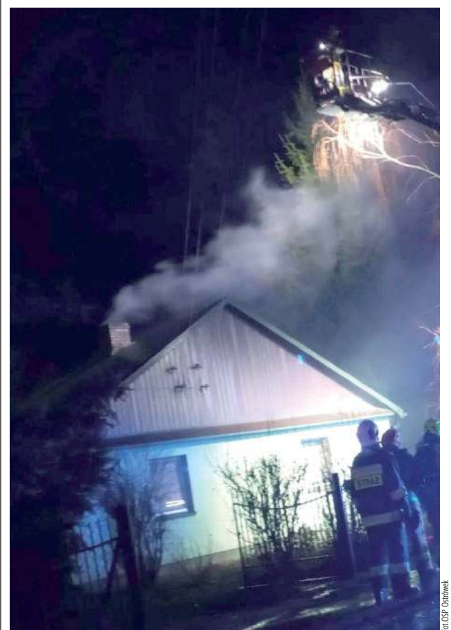
Do pożaru doszło 24 lutego przed godz. 18. - Działania przybyłych zastępów polegały na zabezpieczeniu miejsca zdarzenia, ugaszeniu palącej się sadzy, przeczyszczeniu przewodu kominowego, kontroli przewodu kamerą termowizyjną oraz sprawdzeniu pomieszczeń detektorem wielogazowym pod kątem szkodliwych substancji - opisuje zdarzenie OSP Ostrówek. Oprócz strażaków z Ostrówka w akcji wzięły udział dwa zastępy JRG Lubartów.
