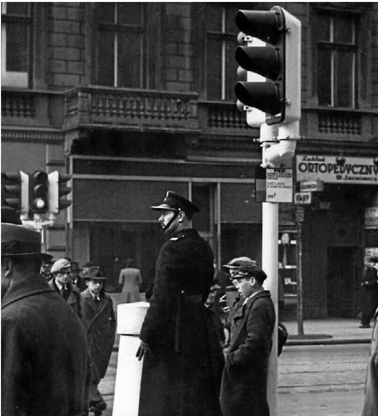
W Warszawie sygnalizacja pojawiła się w latach 20. Na zdjęciu z 1932 sygnalizacja na skrzyżowaniu Marszałkowskiej i Alei Jerozolimskich
