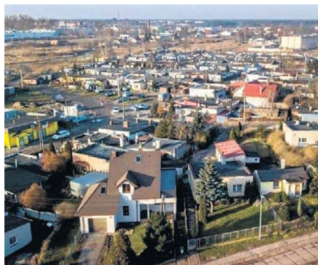
Widok na Dębową Górę i „Ohio” - rok 2021
