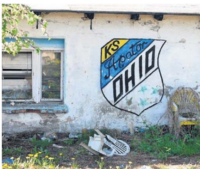
Czas wyburzeń w „Ohio” - rok 2021
