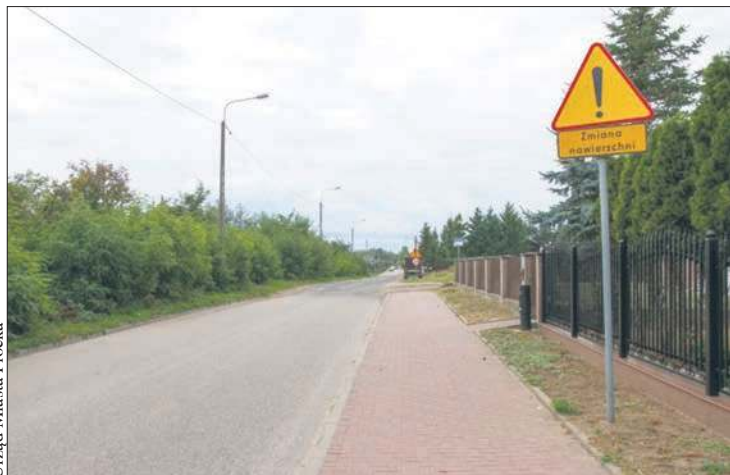
Koniec przebudowy ulicy Browarnej został zaplanowany za rok
