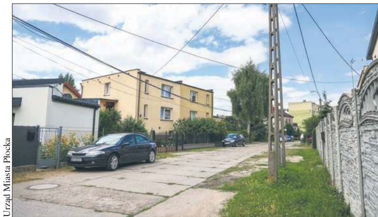
Ulica Gronowa zostanie przebudowana
