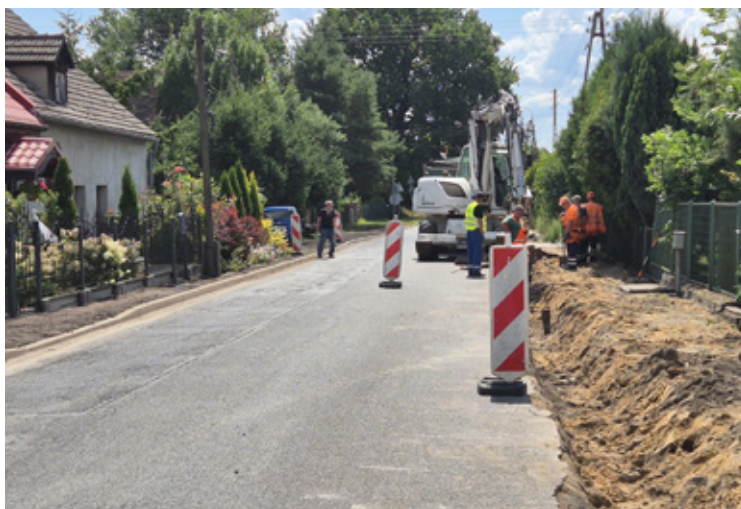
Prace remontowe przy ulicy M. Willmanna w Lubiążu.
