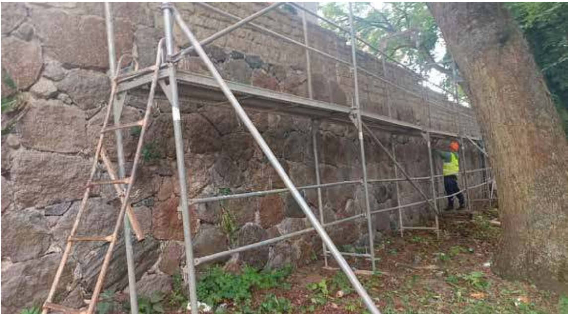
Remont murów obronnych trwa
