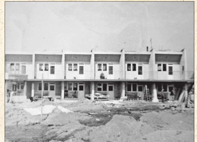
■ Budowa zakładowego domu wypoczynkowego nad morzem
