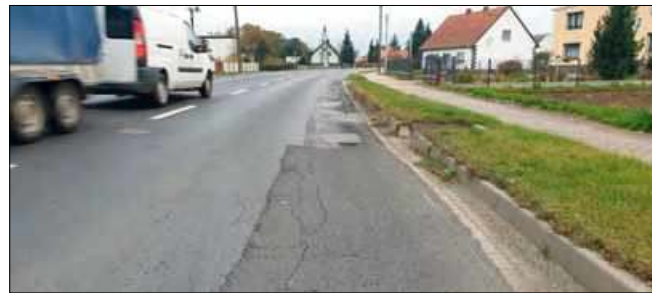
Drogę czeka przebudowa.
