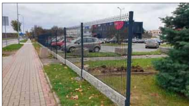
Parking ma być częściowo przebudowany.
