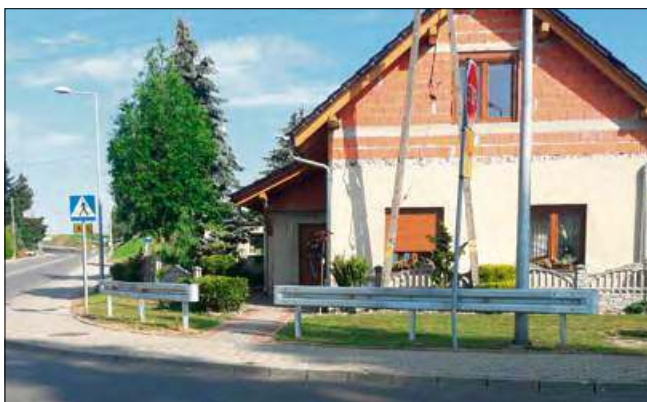
Barierki energochłonne już chronią posesję przed kolejnymi amatorami wciskania gazu do dechy.
