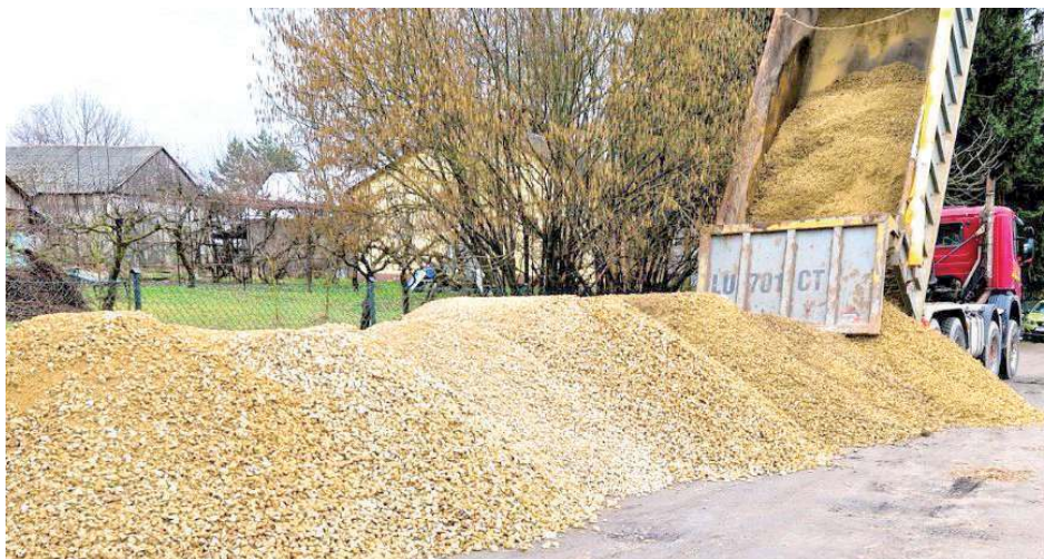
Prace ruszyły na przełomie lutego i marca
