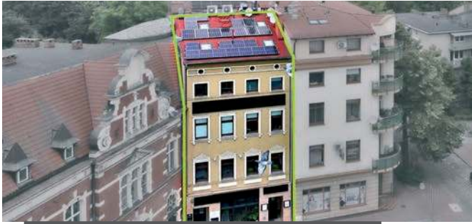
GORZÓW WLKP. | 7 600 000 ZŁ Stylowa kamienica inwestycyjna (729 m 2 ) w centrum. Tel. +48 669 562 330 130-3995
