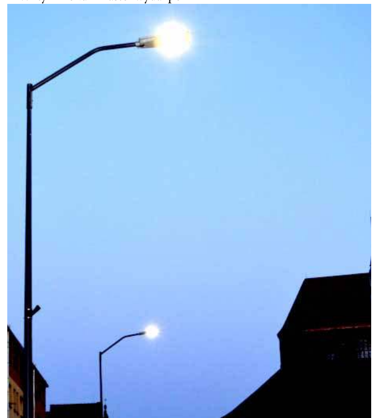
Na ulicy Chełmońskiego zamontowanych zostanie 12 nowych latarni
