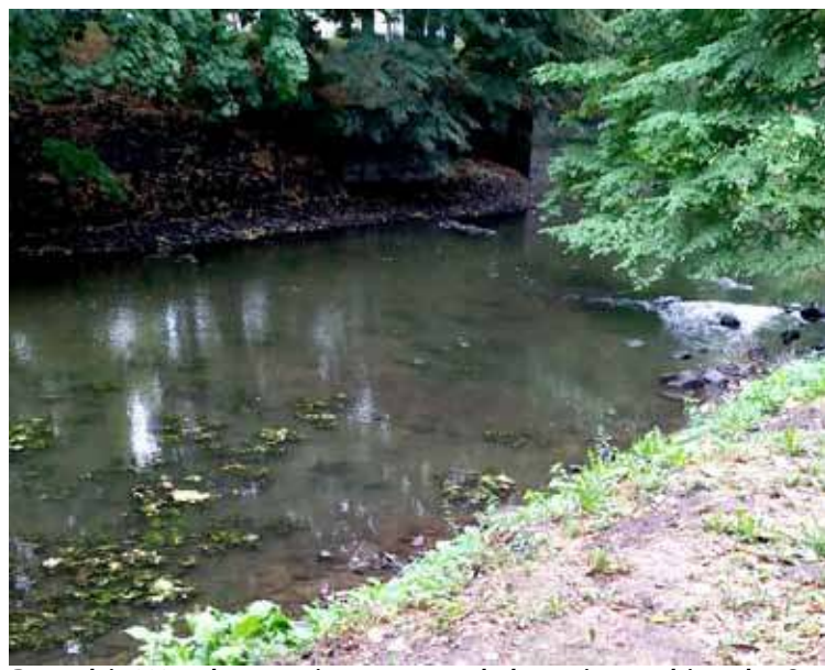
Do grudnia 2021 roku potrwać mają prace przy wałach przeciwpowodziowych w Stargardzie, które kosztować będą 23 mln zł
