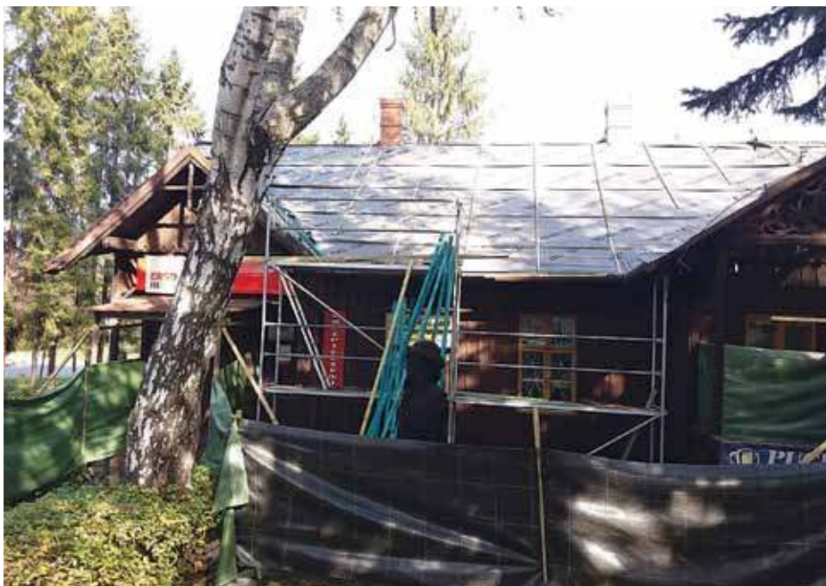
Wymiana pokrycia dachowego na zabytkowym dworku.
