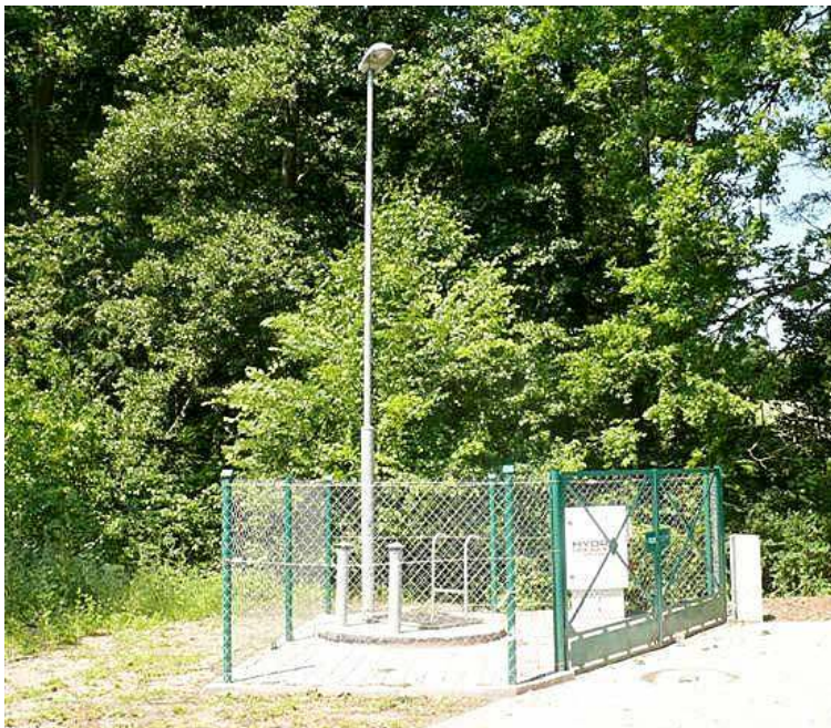
Moryń - jedna z inwestycji wykonanych przy pomocy funduszy z Urzędu Marszałkowskiego
