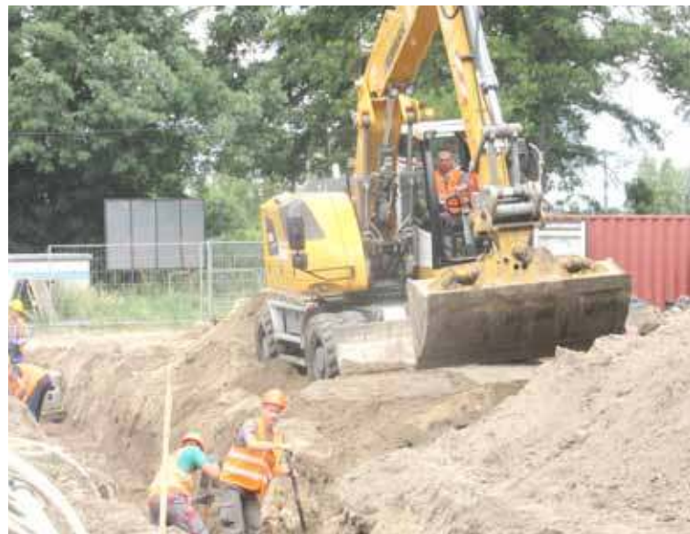
Ruszyły prace ziemne
