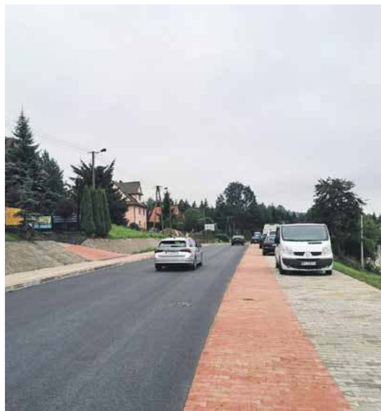
Ulica Zakopiańska jeszcze półtora roku temu w tym miejscu miała głębokie pęknięcia wzdłuż głównej osi.
