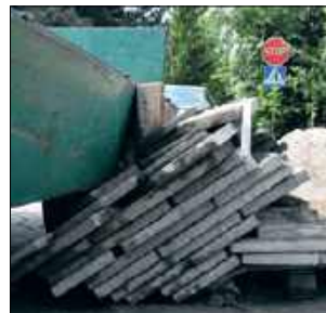
Ciężar płyt spowodował niekontrolowany ruch ładowarki, a znajdujący się na niej 51-latek mężczyzna spadł
