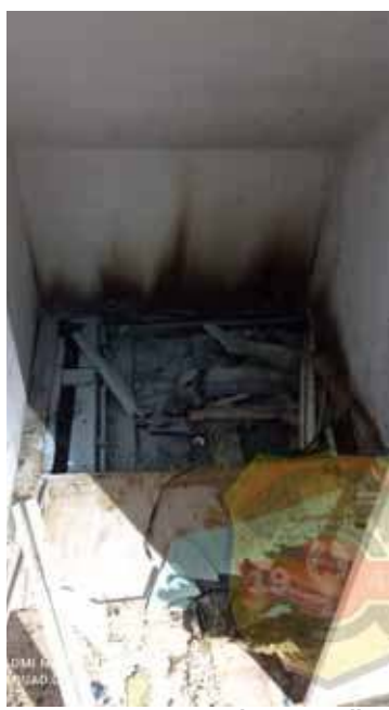
2 stycznia strażacy gasili pożar podłogi w domu jednorodzinnym w miejscowości Studnica. Foto OSP Ińsko
