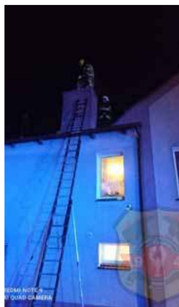
3 stycznia strażacy gasili pożar sadzy w przewodzie kominowym w jednym z domów przy ulicy Bohaterów Warszawy. Foto. OSP Ińsko
