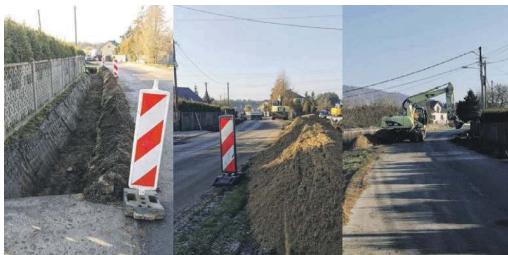
Prace drogowe na ul. Wyrowcowej w Zagórzach
