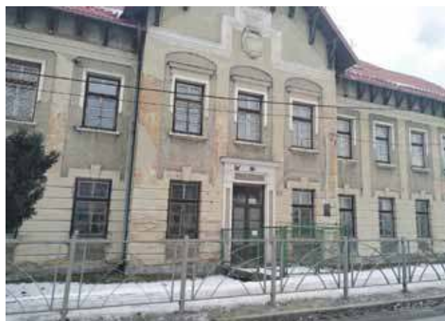
Zabytkowy budynek w centrum Czarnego Dunajca czeka na remont.
