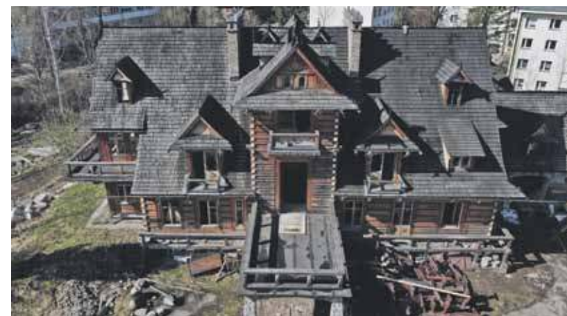
Budynek po dawnej siedzibie PZPR, sprzedany przez komornika, również palił się wiele razy.
