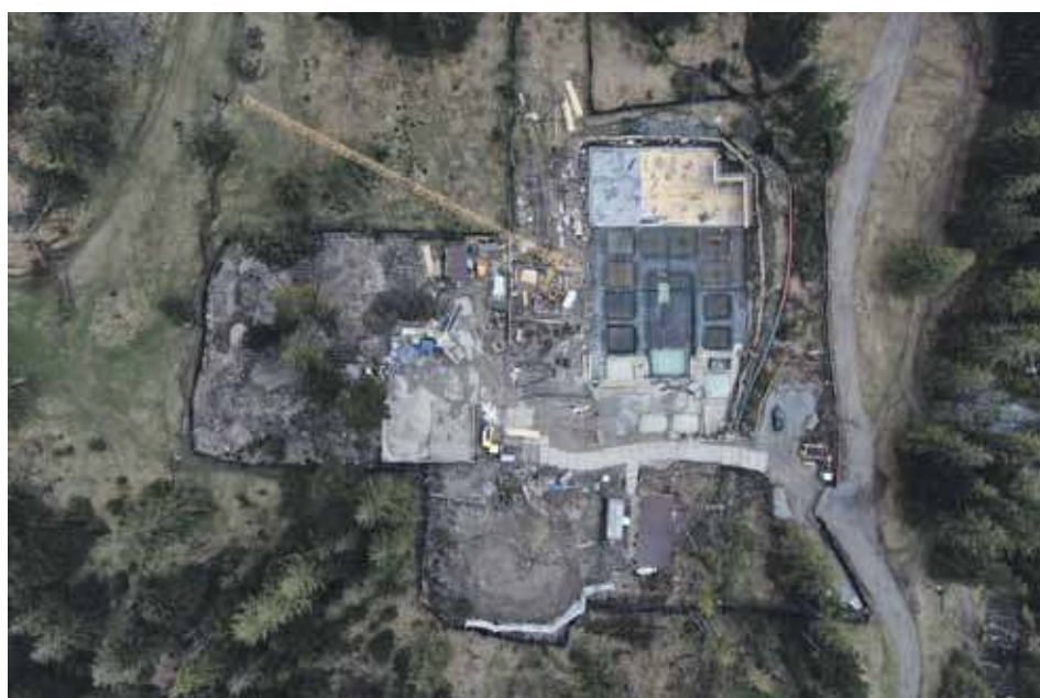
Tak budowa wygląda teraz.
