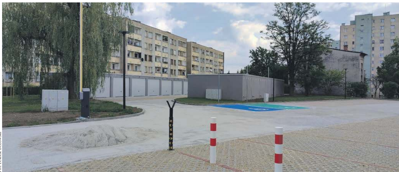
Nowe garaże i miejsca postojowe na osiedlu Północ w Chrzanowie
