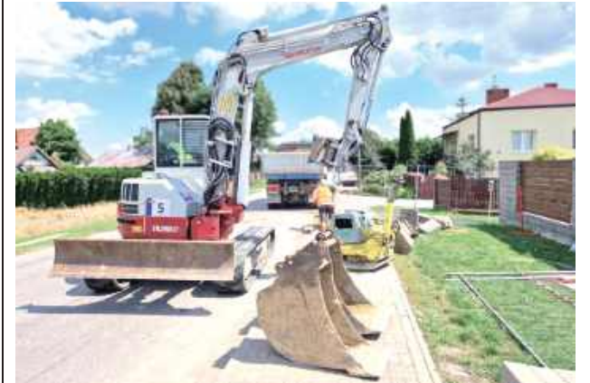
Wyliminowano elementy azbestowe, zastępując je rurami PE
