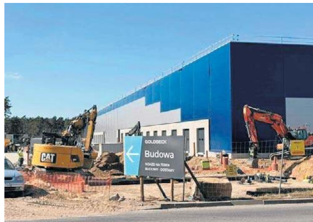
Budowa nowej hali w Bydgoskim Parku Przemysłowo-Technologicznym
