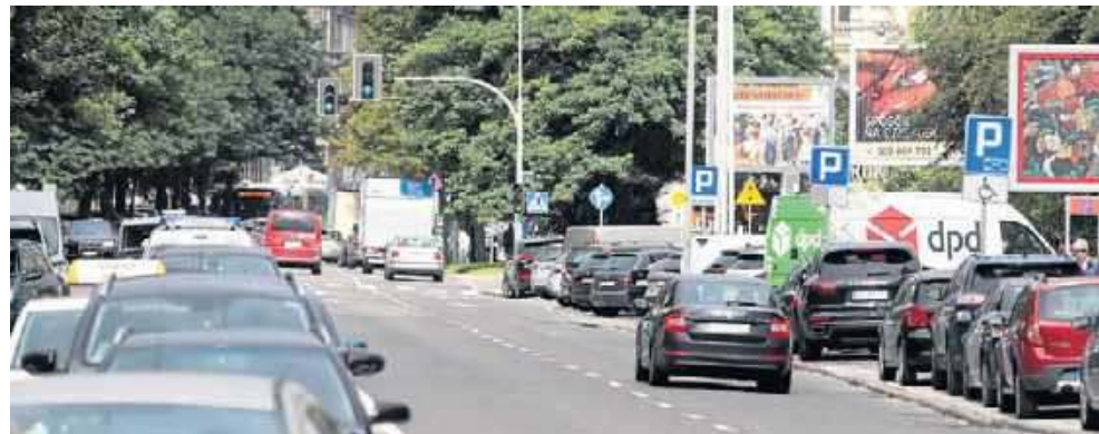
Przebudowa głównej ulicy Szczecina zacznie się na odcinku między krzyżówką z ul. Jagiellońską a pl. Zgody. Ten fragment alei będzie remontowany do wiosny przyszłego roku.
